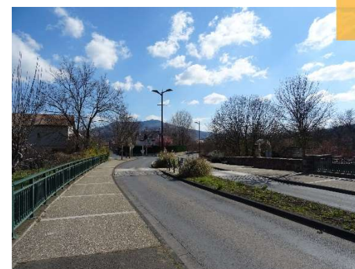
Aménagement piéton sécurisant (Les Martres-de- Veyre) // CP : Citadia Conseil
