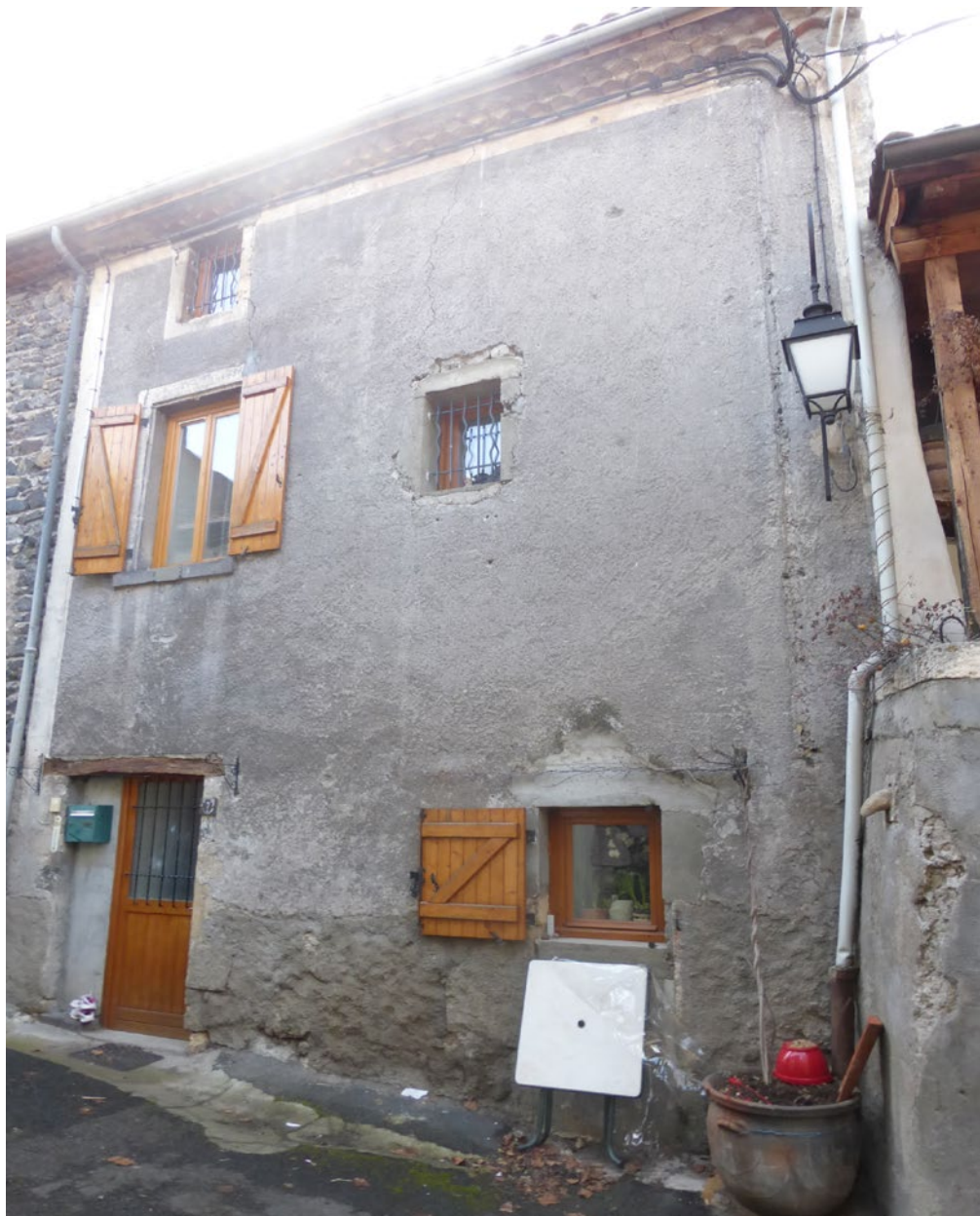
Les enduits ciments conduisent à la dégradation prématurée des maçonneries, qui demeurent cachées par l'enduit, qui s'altère peu. Les volets en «Z» sont des produits n'ayant pas leur place à Saint-Saturnin.
