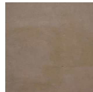
Enduit lissé à la truelle
