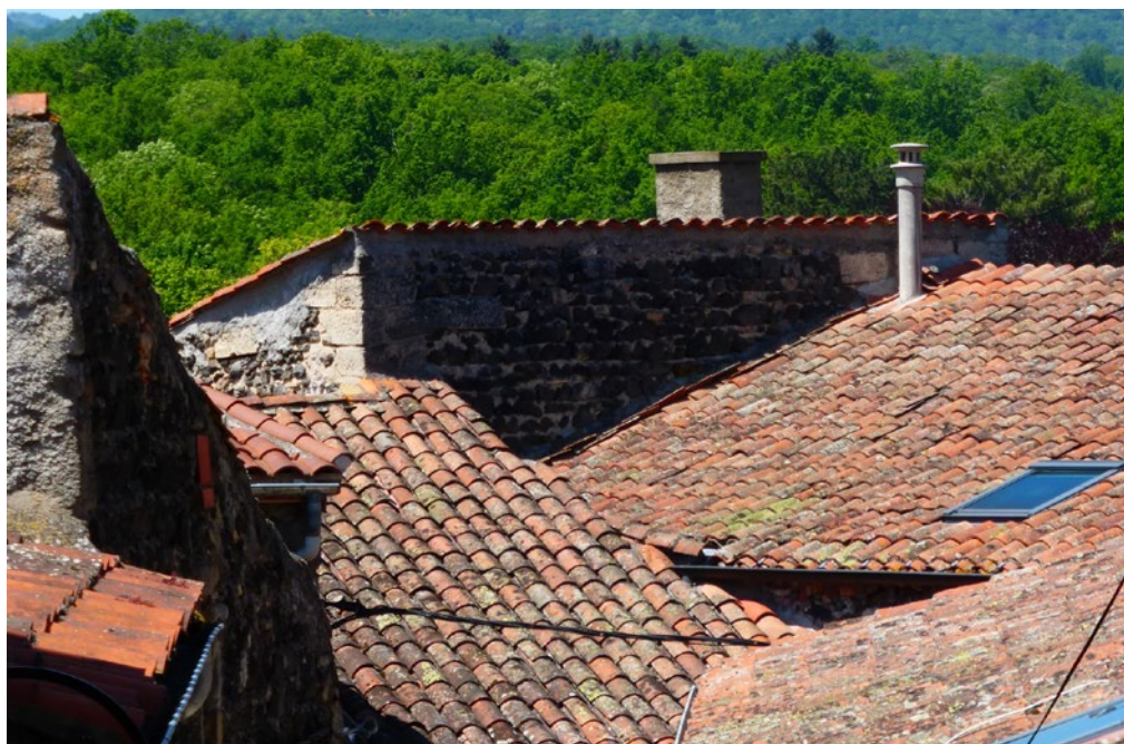
La terre cuite est très présente sur le territoire, car couramment utilisée : encadrements de fenêtres, corniches, tuiles de rives, tuiles. Le caractère peu noble la réserve surtout aux édifices agricoles.
