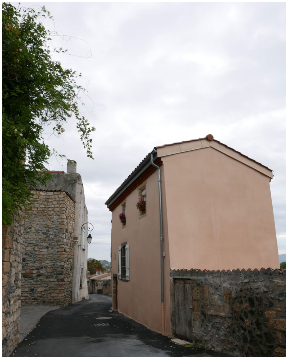
L'isolation des toitures entraînant surélévation a un impact très important sur le bâti, et conduisent à une dégradation de la qualité du paysage urbain.
