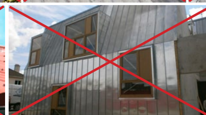
Revêtements interdits : tôles, bacs aciers, tuiles bétons, revêtements réfléchissants, bardages, fibrociment non recouvert de tuiles...
