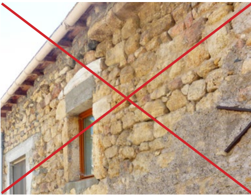
Les matériaux destinés à être enduits laissés apparents sont proscrits.
