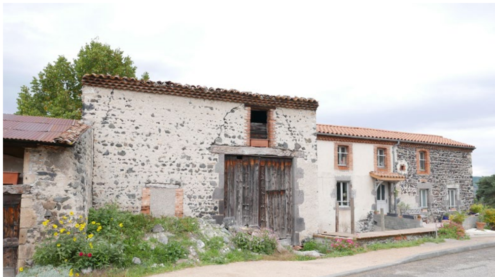
Les modénatures très simples du bâti soulignent la prééminence des génoises, qui sont à conserver.
