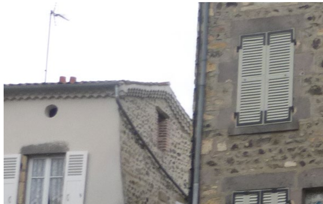
En haut à gauche : les débords de chevron, que les génoises protègent de l'humidité. En haut à droite, une génoise en retour sur pignon, formant un fronton. En bas, un cas rare génoise sur pignon rue du Marché.
