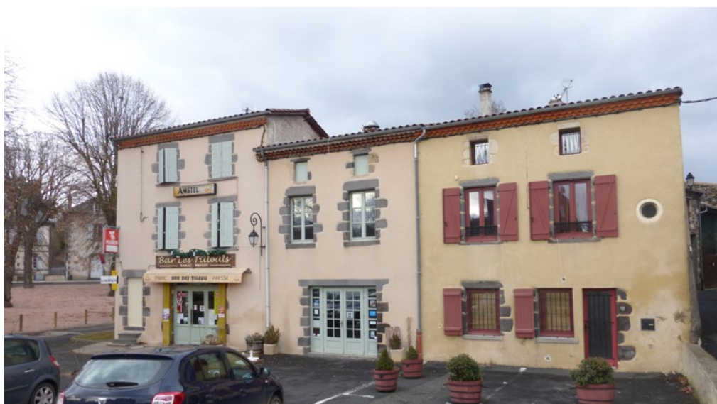
Les façades en moellons de pierre sont souvent enduites. Les chambranles sont en pierre ou en briques, et ils forment avec les génoises les seuls éléments décoratifs. Les chaînages d'angles sont rares.
