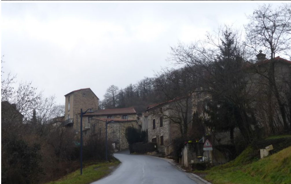
Le mobilier urbain joue un rôle pouvant être important : panneaux de signalisation, consignes diverses, ne sont pas pour améliorer l'espace urbain. En bas, l'entrée est de Chadrat, assez qualitative.
