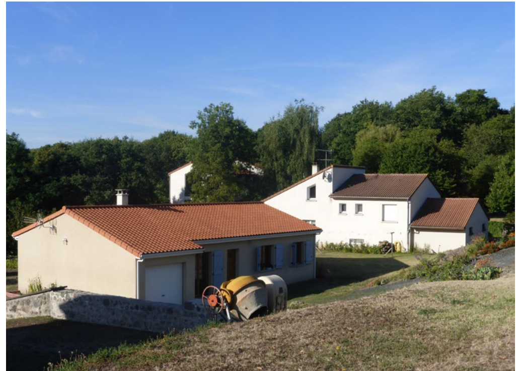
Une toiture simple et (au fond) une toiture complexe, inadaptée au contexte saturninois.
