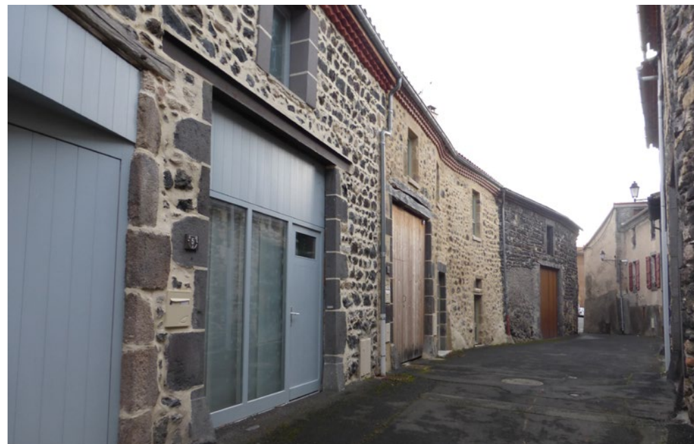
En haut, une maison vigneronne typique : escalier, auvent, terrasse. En bas, la rue des Granges : porte charretière, fenêtre carrée, un seul étage, pas d'enduit.
