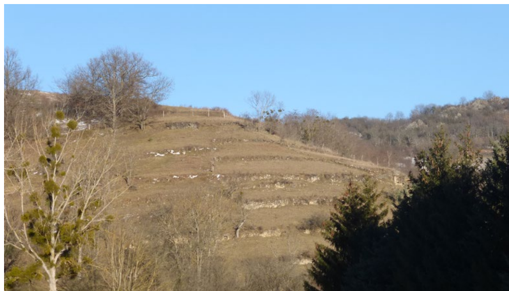
Les paysages saturninois sont particulièrement marqués et modelés par les murs de clôture et de soutènement en pierre sèche ou maçonnée.
