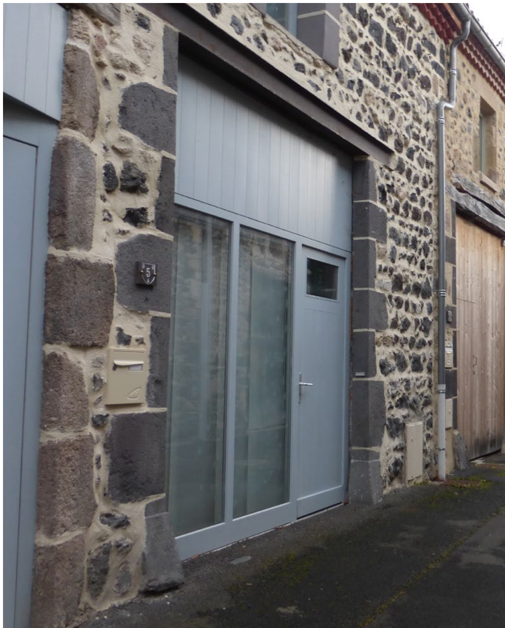
Les portes de grange peuvent être transformées, à l'occasion de réhabilitations. En revanche, cette transformation doit être respectueuse du bâti traditionnel (volumétrie, transparences, matériaux...)
