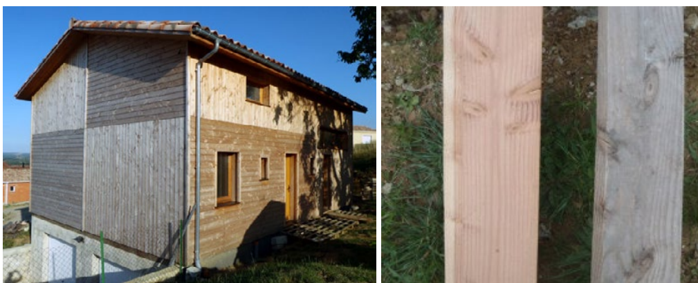
Le vieillissement du douglas : à gauche, un an après la pose. A droite, planche neuve et trois ans après. Le mélèze est un bois devenant gris également.
