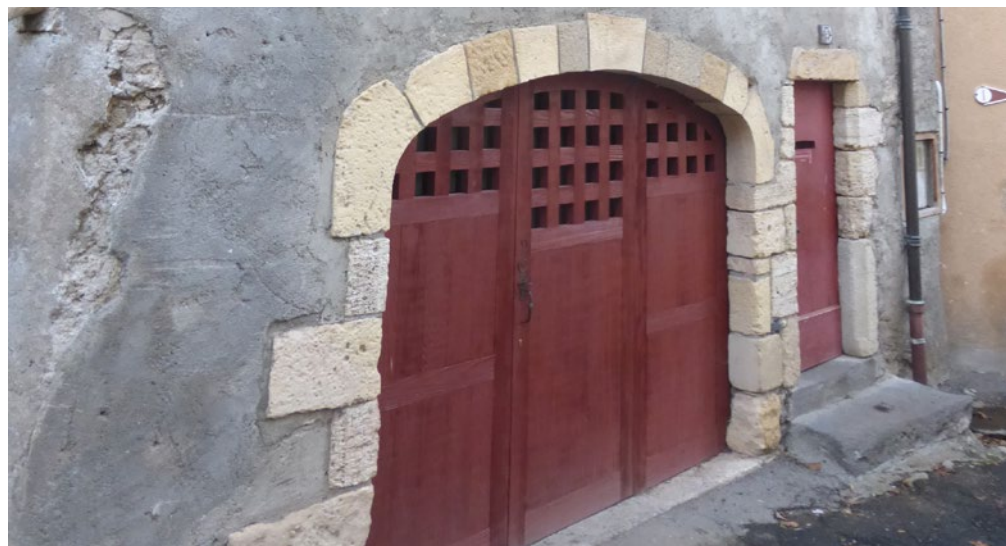
En haut : porte charretière type, surmontée d'une fenêtre fenière. En bas, porte en anse de panier d'une demeure viticole située rue des Gourlettes.
