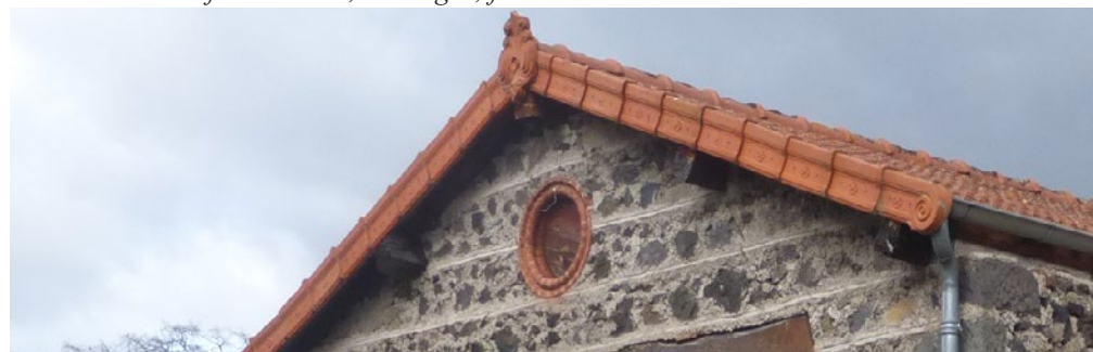
Les rives anciennes, souvent ouvragées, sont à préserver.
