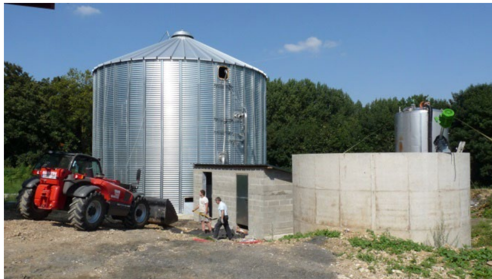
Une unité de méthanisation de petite dimension. Elles peuvent poser d'importants problèmes d'intégration paysagère, même dissimulées (c'est à dire teintes en vert.) Source : Terre.net
