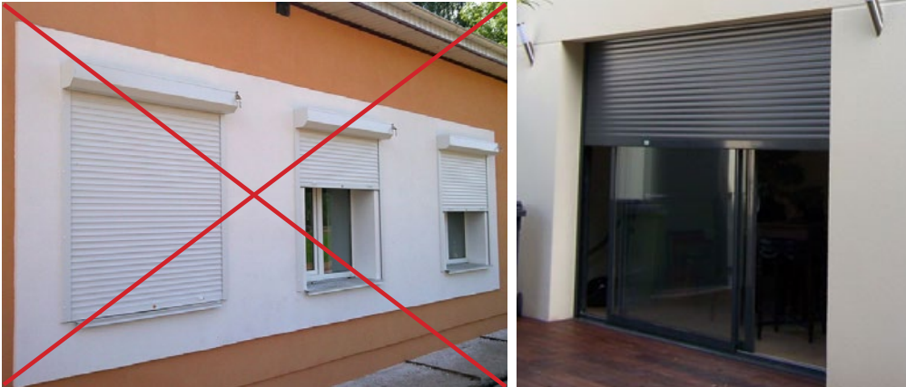
A gauche, des volets roulants blancs et saillants, donc proscrits. A droite, le volet roulant est intégré et de la couleur de la menuiserie.
