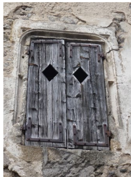
En haut : les baies à linteau cintré sont également présentes sur la commune, mais demeurent peu courantes. En bas, deux exemples de contrevents anciens : ferrures en «U» typiques à gauche, contrevent plein très rustique à droite.
