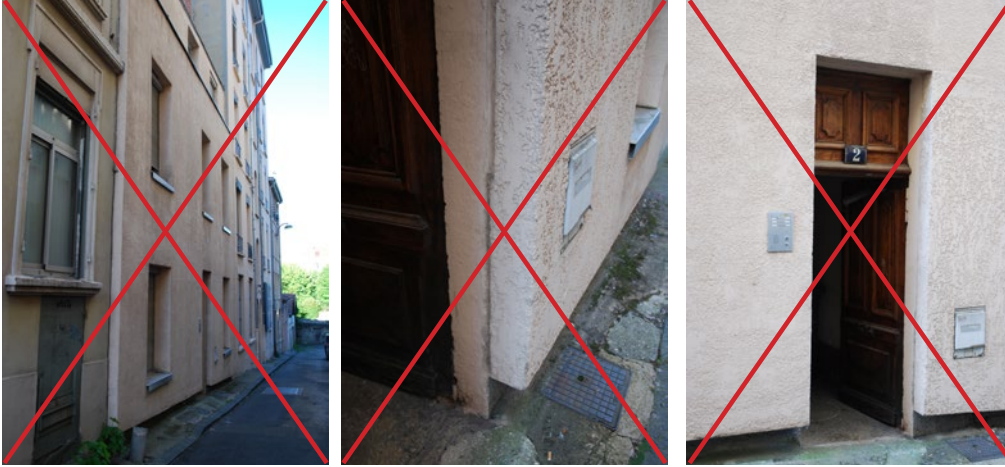
Les surépaisseurs de plus de trois centimètres en façade sont prosrites. De fait, les isolations thermiques extérieures traditionnelles sont impossibles.
