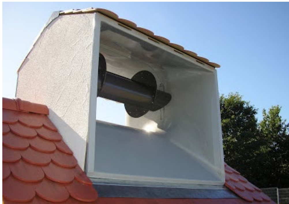
Eolienne compacte «sans mat». Ces éoliennes sont conçues pour s'intégrer au bâti, mais modifient malgré tout les volumes de l'édifice. Ceux-ci sont par ailleurs très simples à Saint-Saturnin.
