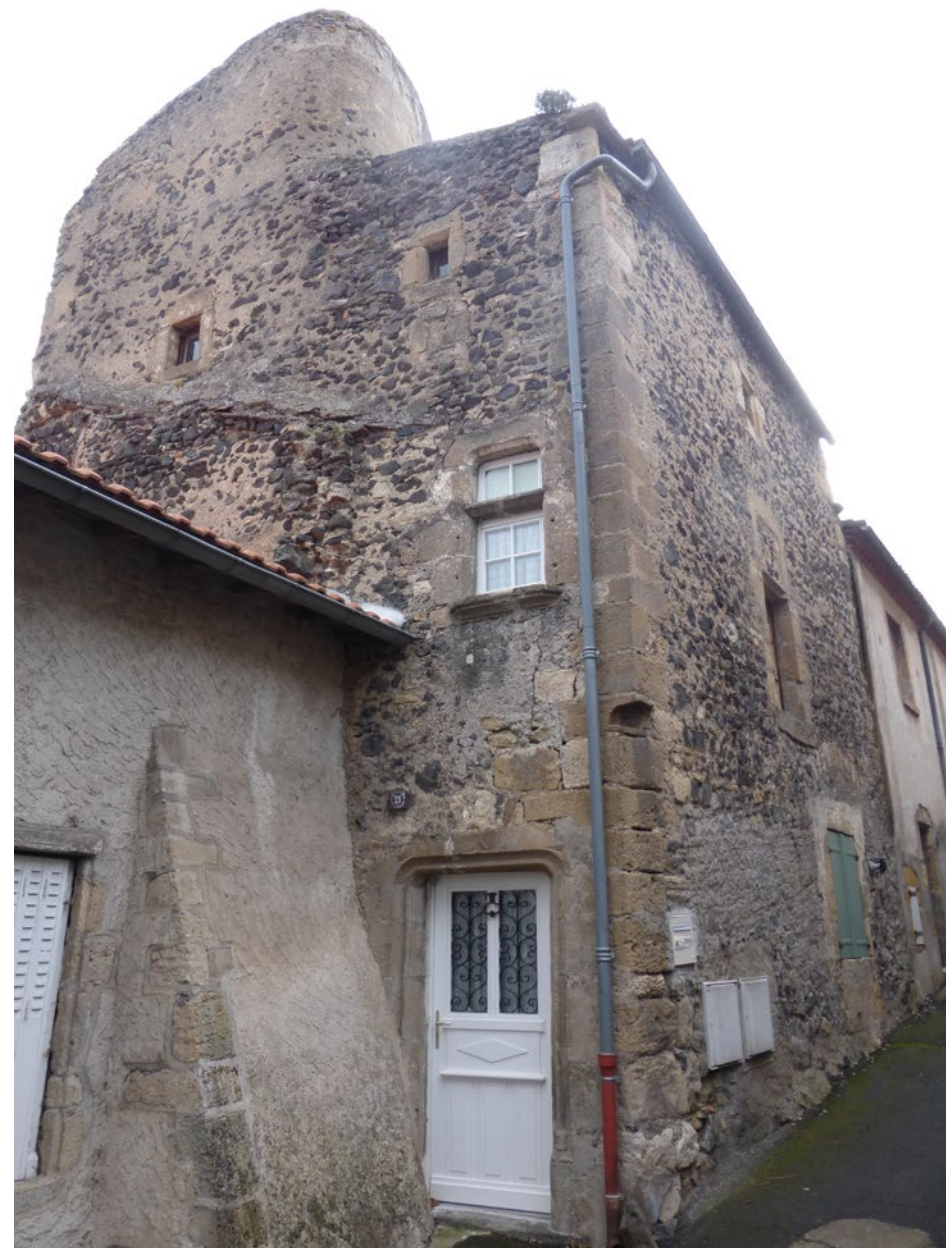
Certaines demeures intègrent également des éléments défensifs d'importance - il est possible que la demeure ait phagocyté le mur, à l'image du bâti rue Côte Gros-Jean ou de la rue Noble.
