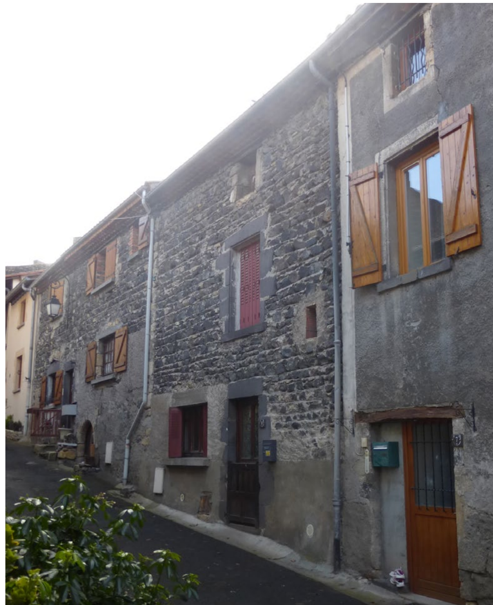
Les façades doivent être enduites par un enduit couvrant, taloché fin, ou par un enduit à pierres vues, qui ne laisse visible que la surface assisée des pierres (les joints ne sont pas creux). De telles façades non enduites peuvent s'altérer prématurément.
