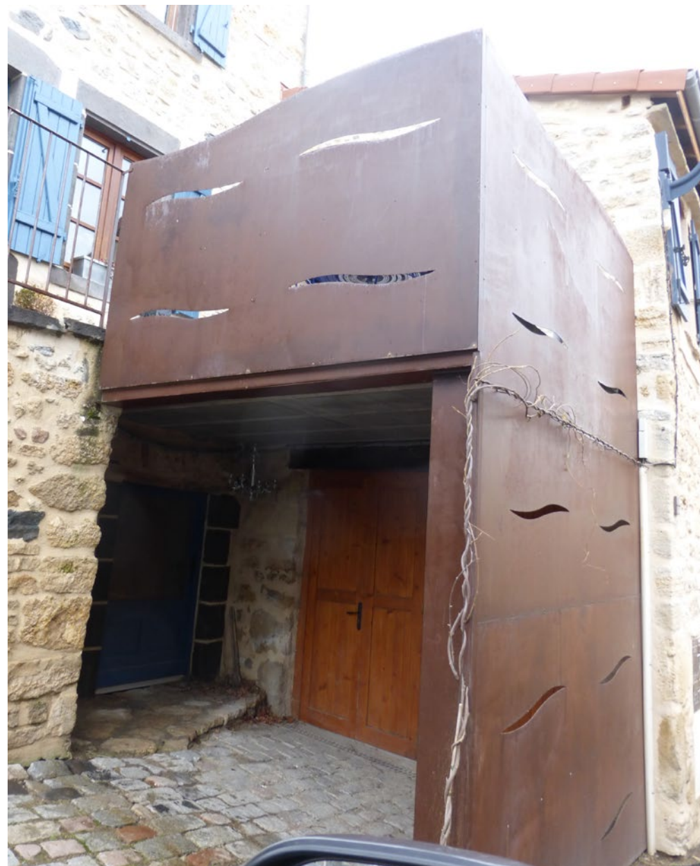
De nombreux matériaux peu communs, car étrangers au site, sont apparus et ponctuent le territoire communal : importantes surfaces métalliques, plastiques...
