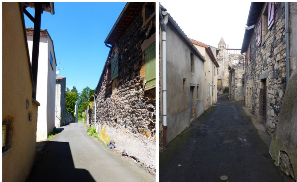
Différentes rues des faubourgs, avec de multiples ambiances urbaines. Le gabarit des immeubles, leur volumétrie, les matériaux utilisés, créent toutefois un aspect d'ensemble.
