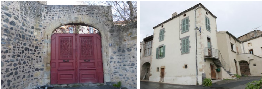
Les enduits peuvent être couvrants (à droite) ou à pierres vues.
