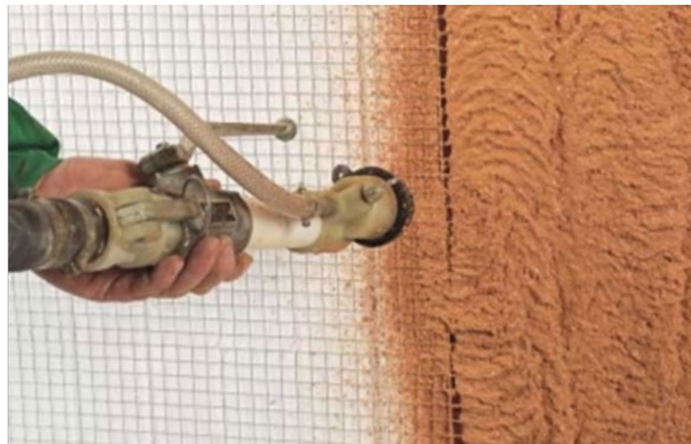
L'isolation par l'extérieur : traditionnelle (fortes épaisseurs) et par enduits isolants. L'enduit isolant est mieux adapté aux bâtis anciens, du fait de sa finesse et de sa capacité de régulation hygrométrique.
