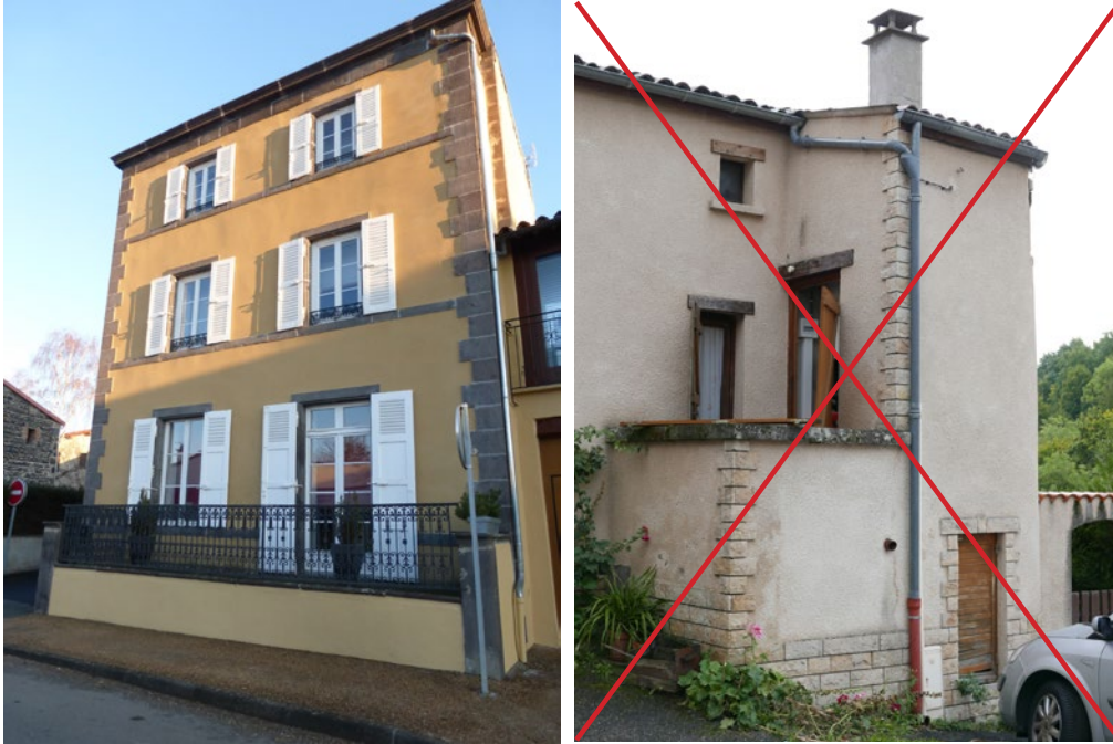
La pierre de taille est très utilisée à Saint-Saturnin, mais de manière plutôt ponctuelle (encadrements, chaînes d'angle). Les placages sont interdits.
