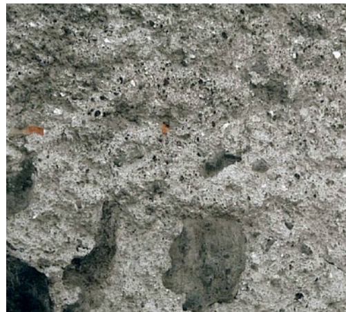
Enduits anciens à pierres vues à la chaux aérienne : sables et agrégats grossiers.
