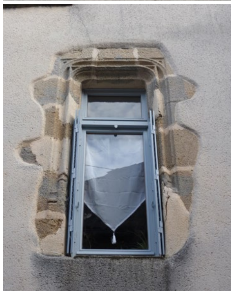
En haut : à gauche, le soubassement est inutilement mis en valeur. L'enduit doit couvrir la façade dans son ensemble. En haut à droite, les joints tirés au fer ne produisent pas un effet satisfaisant. En bas, des enduits trop épais, qui soulignent «en creux» les pierres de taille...
