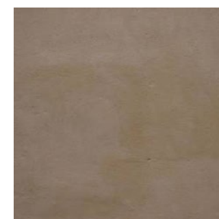
Enduit lissé à la truelle
