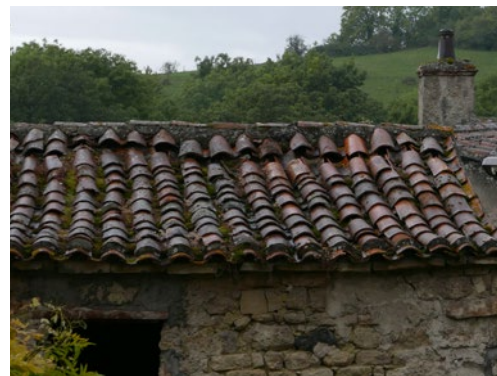
Les tuiles creuses et les tuiles mécaniques à emboîtement grandes ondes sont autorisées sur les constructions neuves ainsi que sur certaines constructions existantes.
