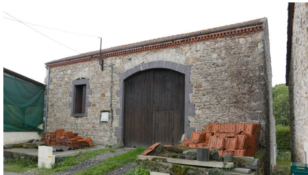
Les génoises en briques sont bien représentées, notamment sur les édifices du XIXème siècle. Les motifs varient des plus simples aux plus complexes.
