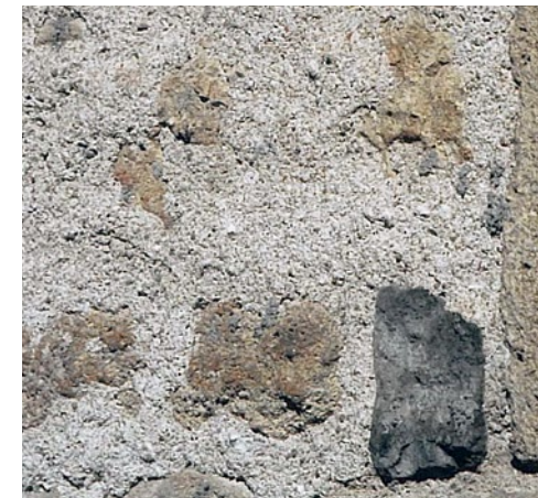
Enduits anciens à pierres vues à la chaux aérienne : sables et agrégats grossiers.
