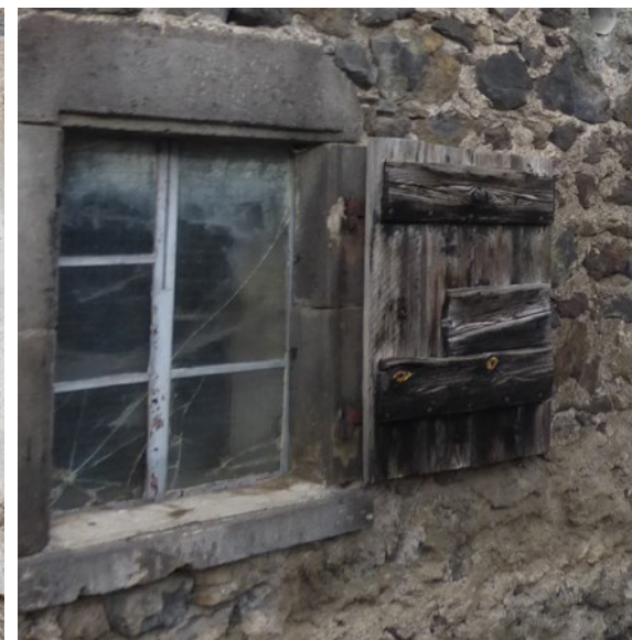
En haut : les baies à linteau cintré sont également présentes sur la commune, mais demeurent peu courantes. En bas, deux exemples de contrevents anciens : ferrures en «U» typiques à gauche, contrevent plein très rustique à droite.
