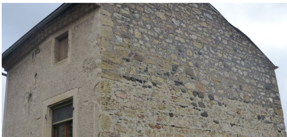
Les pierres à bâtir sont également en arkozes, mais plus communément en pierre de laves, omniprésentes sur le territoire. L'usage de ces deux pierres confère une forte identité à Saint-Saturnin.
