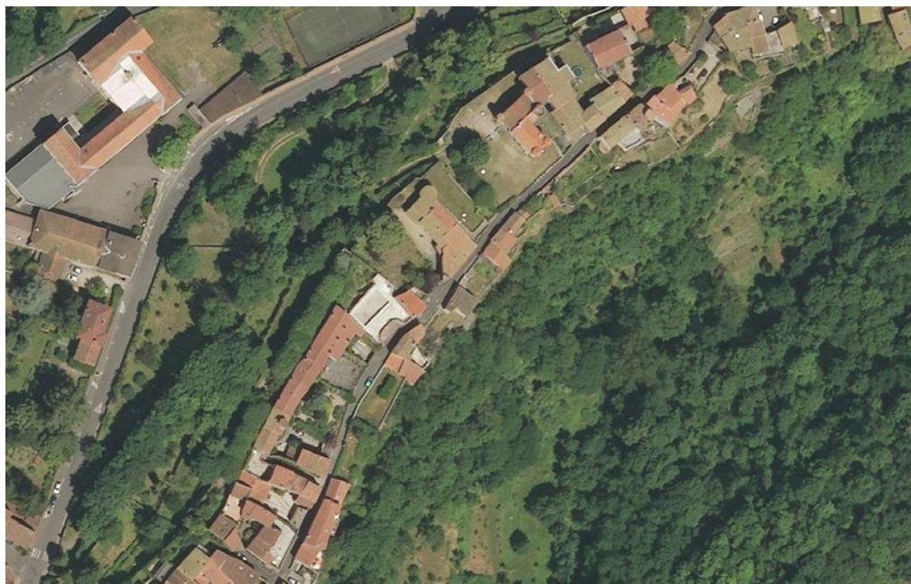
Le faubourg de la Rochemanie est riche d'effets volumétriques : cours fermées, doubles épaisseurs de bâti, édifices présentant pignon sur rue, courettes de service. La rue Noble est également hétéroclite.
