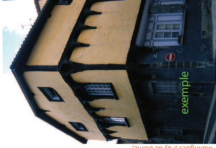
Le dégagement des pans de bois ne devrait intervenir que si les structures cachées présentent un intérêt esthétique, ce qui est rarement le cas. Seules les sablières et les aisseliers les soutenant sont destinés à rester vus (ci-dessus une restauration récente dans le Puy de Dôme).
