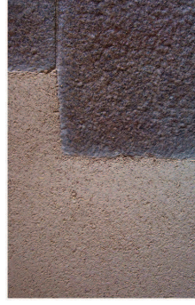
MORTIER CHAUX-CHANVRE Selon la nature des fibres utilisées, un enduit chaux-chanvre offre un aspect proche des enduits traditionnels tout en améliorant les qualités thermiques des maçonneries
