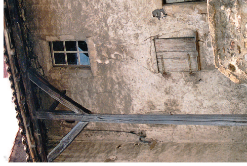
Contrairement à une idée reçue, l'architecture rurale est enduite ou destinée à l'être, du moins pour les bâtiments d'habitation. Si la qualité de la pierre le permet, on peut, au cas par cas, conserver des maçonneries simplement rejointoyées (murs pignons, par exemple).
