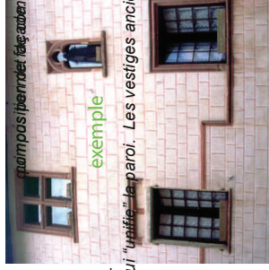
Badigeon en trompe-l'œil simulatant un faux-appareil qui "unifie" la paroi. Les vestiges anciens sont bien identifiés par leur mise en couleur (rose) discrète. Ce procédé n'est cependant pas à l'apportée de n'importe quel artisan.
