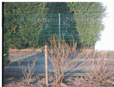
Un grillage plastifié vert viendra souligner la haie
